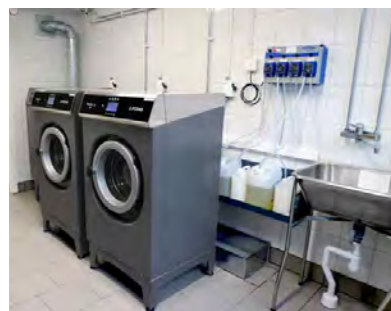
Pump-o-tronic kan styra upp till 4 pumpar för automatisk dosering av olika tvättmedel och sköljmedel.
